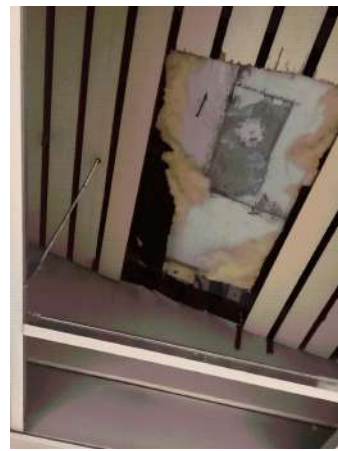
Prélèvement - P123 : R+0 / Box 1 - Enduit- (Absence d'amiante)
