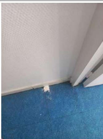
Prélèvement - P33 : R+1 / Dégagement 3 - Colle- (Présence d'amiante)
