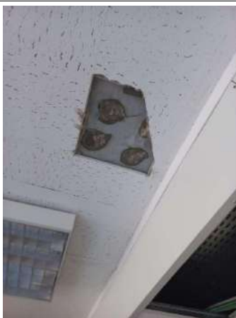
Prélèvement - P50 : R+1 / Archives - Colle- (Présence d'amiante)
