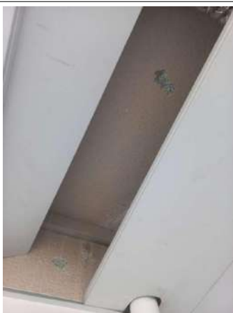
Prélèvement - P44 : R+1 / Sanitaires homme - Enduit- (Présence d'amiante)
