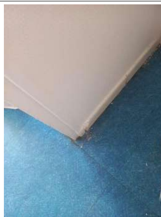
Prélèvement - P34 : R+1 / Dégagement 3 - Colle de plinthe- (Absence d'amiante)
