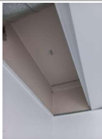
Prélèvement - P45 : R+1 / Dégagement 3 - Enduit- (Présence d'amiante)
