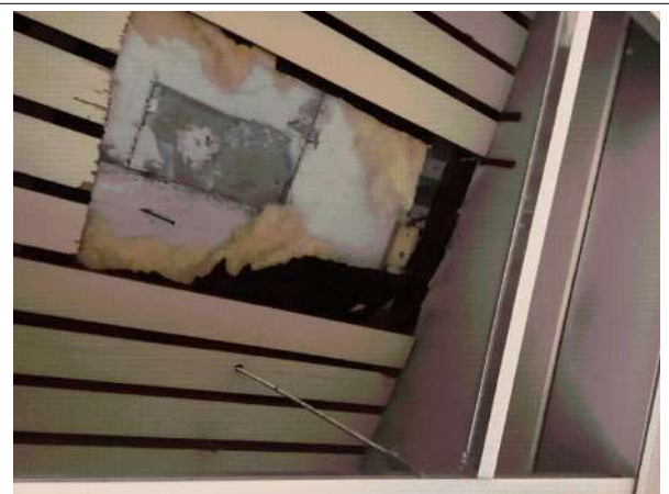
Prélèvement - P125 : R+0 / Box 1 - Isolant- (Absence d'amiante)
