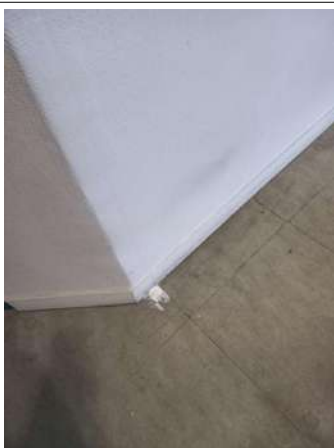
Prélèvement - P12 : R+0 / Salle d'attente - Colle- (Absence d'amiante)
