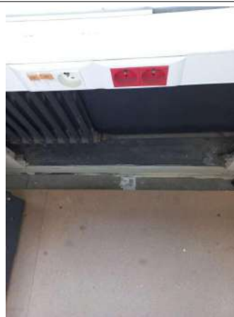
Prélèvement - P85 : R+1 / Archives dynamique - Colle- (Présence d'amiante)
