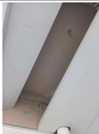
Prélèvement - P43 : R+1 / Dégagement 3 - Enduit- (Présence d'amiante)
