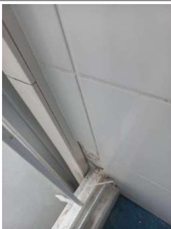
Prélèvement - P36 : R+1 / Sanitaires homme - Colle de faïence - (Absence d'amiante)
