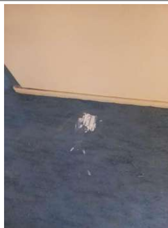
Prélèvement - P89 : R+1 / Service courrier général - Colle- (Présence d'amiante)
