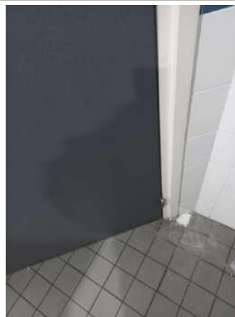
Prélèvement - P02 : R+0 / Sanitaires 2 - Colle- (Présence d'amiante)
