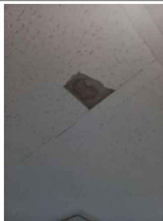
Prélèvement - P51 : R+1 / Local Enquêteur - Colle- (Présence d'amiante)
