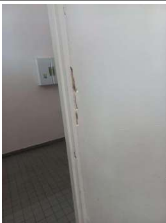
Prélèvement - P29 : R+0 / Box 1 - Panneau de cloison- (Absence d'amiante)
