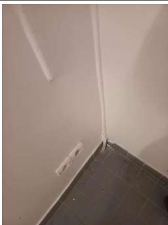
Prélèvement - P03 : R+0 / Tisanerie et vestiaires - Colle de plinthe- (Absence d'amiante)
