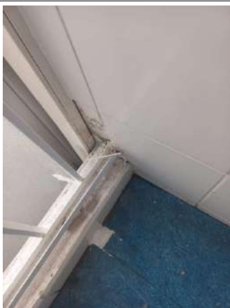
Prélèvement - P52 : R+2 / Sanitaires Femmes - Colle- (Présence d'amiante)
