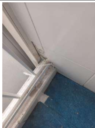
Prélèvement - P32 : R+1 / Sanitaires homme - Colle non bitumineuse- (Présence d'amiante)
