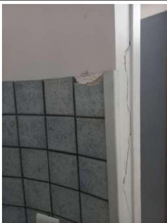
Prélèvement - P06 : R+0 / Tisanerie et vestiaires - Colle de faïence- (Absence d'amiante)
