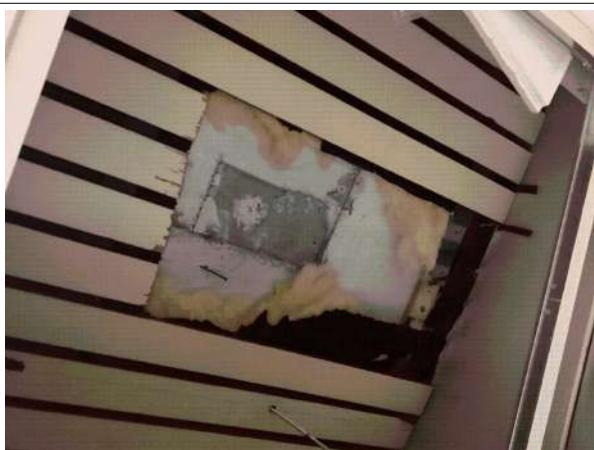
Prélèvement - P124 : R+0 / Bureau trésorier adjoint - Isolant- (Absence d'amiante)
