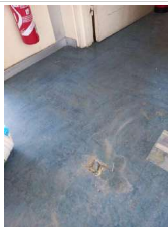
Prélèvement - P107 : R+2 / Bureau secteur nogent -joinville - Colle- (Présence d'amiante)
